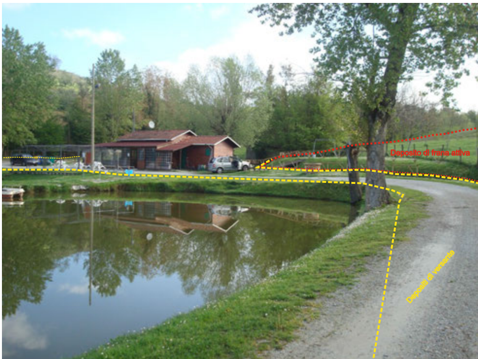
Foto 5- Vista dell'area oggetto di proposta di nuova perimetrazione. In particolare si evidenziano i limiti fra i due depositi come proposti.
