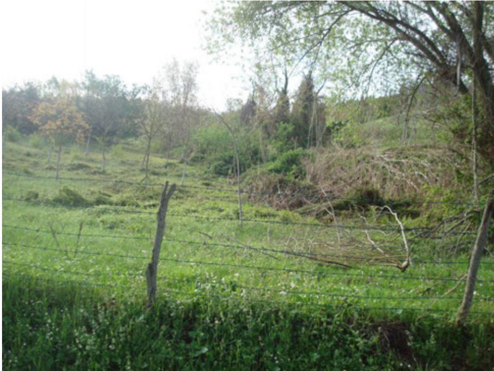
Foto 2- Porzione del fosso in erosione che lambisce i depositi di frana sul lato Ovest.
