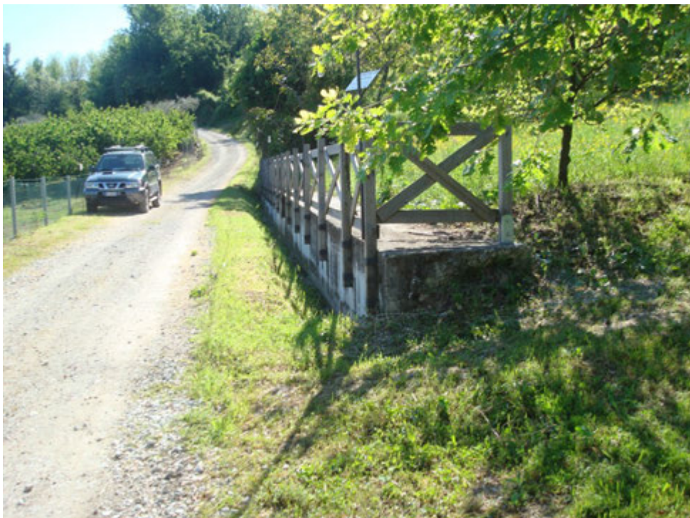
Foto 3- Opera di contenimento sulla vicinale (Via Riva)
